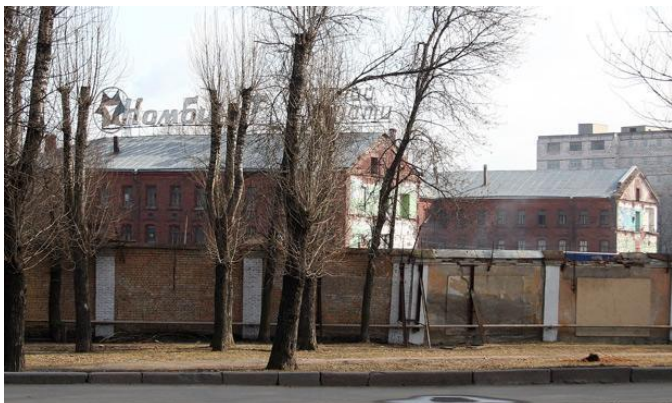
Современный вид главного корпуса бывшей Карточной фабрики со стороны Проспекта Обуховской обороны
